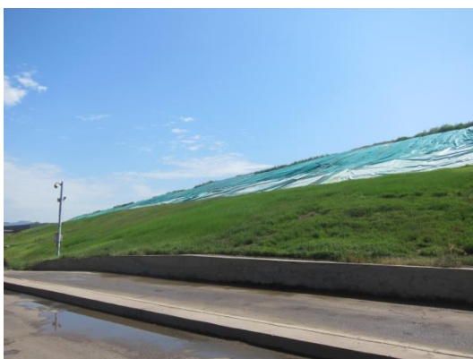
阿苏卫垃圾卫生填埋场现状照片
