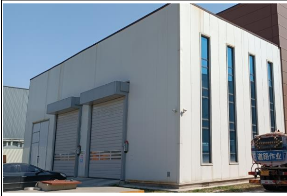
餐厨垃圾处理车间
