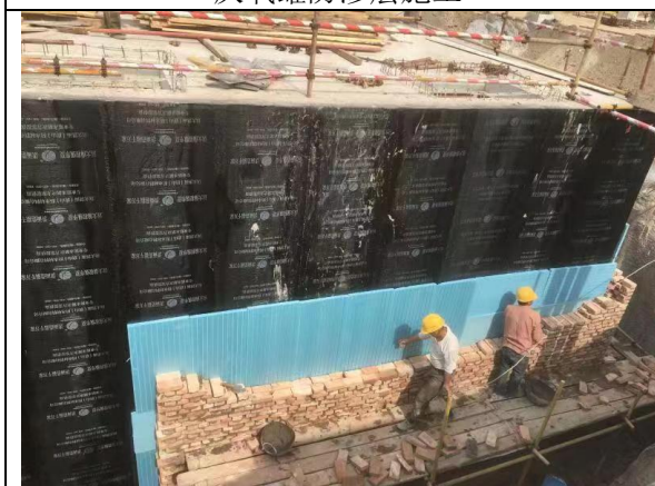
池体防渗层施工
