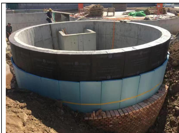
厌氧罐防渗层施工
