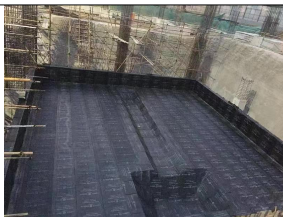
池体防渗层施工
